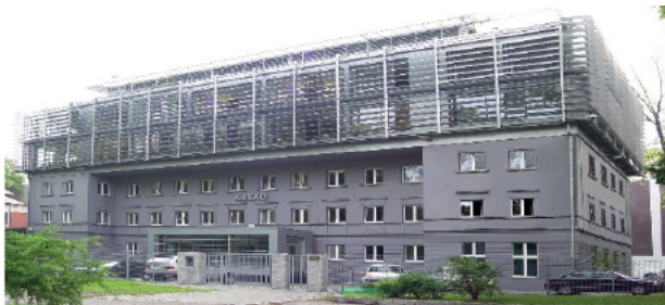
Siedziba WASKO S.A. Warszawa, ul. Czackiego
