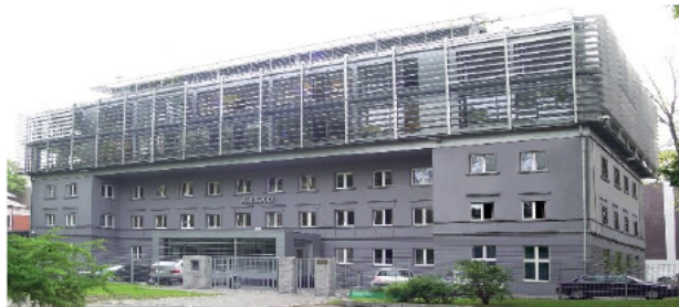
Siedziba WASKO S.A. Warszawa, ul. Czackiego
